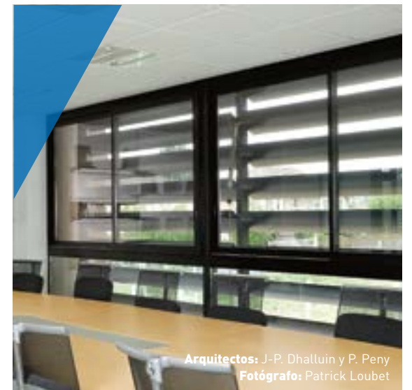
Lamas de 300 mm motorizadas - Inclinación 45°
