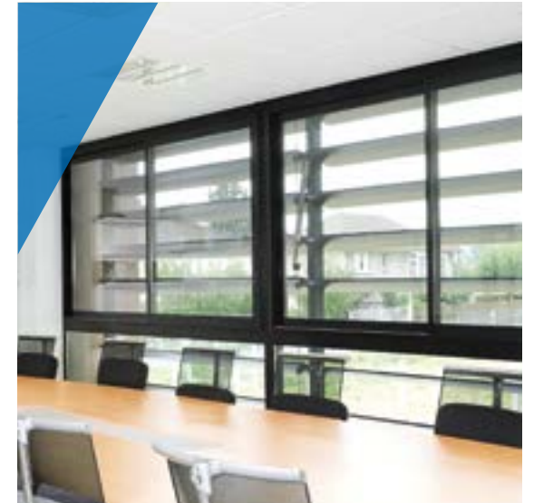
Lamas de 300 mm motorizadas - Inclinación 15°
